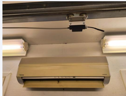
IR-lähetin osoittaa lämpöpumpun vastaanottimeen
